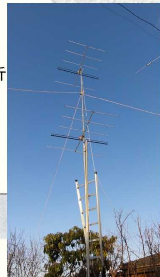
FM受信用 ダイバシティ アンテナの例
